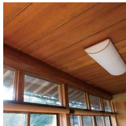
ケヤキは柱、スギは梁、床、天井材にふんだんに使用している。
