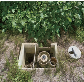
「地下水制御システムFOEAS」の自動給水装置。水稻、大豆、大麦それぞれに最適な地下水位を維持し、適切な水管理ができる。
